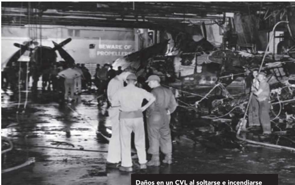
Daños en un CVL al soltarse e incendiarse aviones en la cubierta hangar
