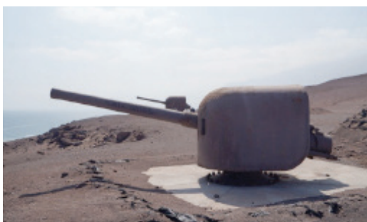
■ Batería doble de 152/50 mm, emplazada al interior del fuerte Condell, en sector conocido como Lagarto 2 en Punta Gruesa.
