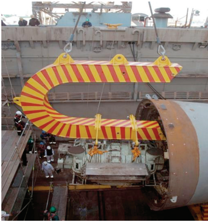
■ Desmonte del motor propulsor para llevarlo a taller.
