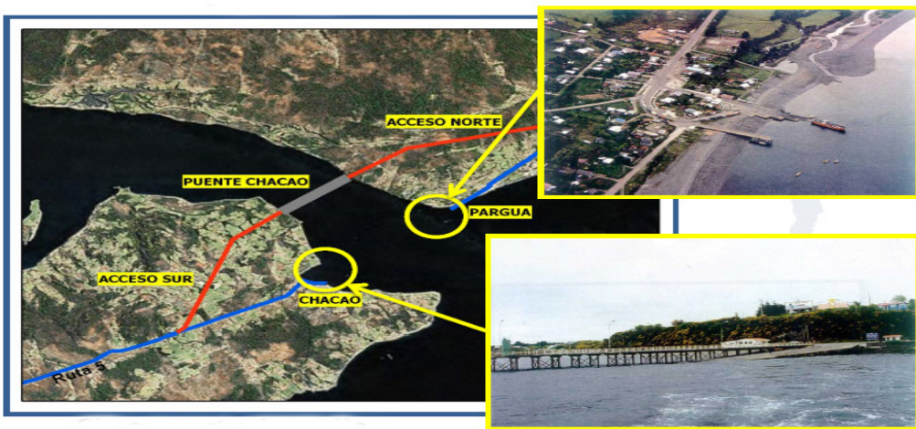
■ Vista aérea proyecto puente Chacao, presentación técnica, MOP.
