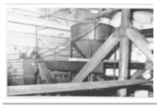
■ Trabajo de reparación.
