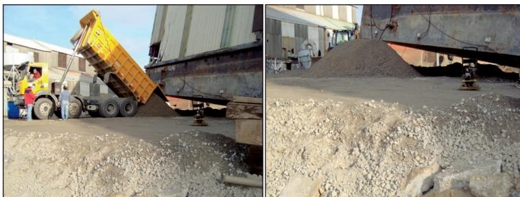
Compactado del terreno e instalación de los roller bags.
