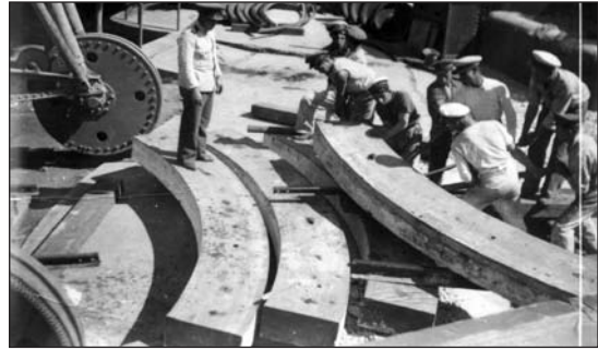
Faenas de traslado e instalación de la Batería de 280 mm. en el Fuerte O'Higgins.
