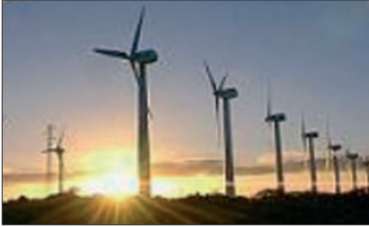
Energía eólica en base a aerogeneradores.
