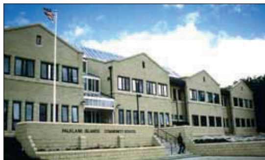
Vista general de la nueva escuela comunitaria.
