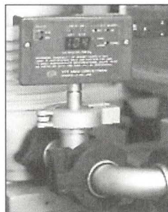
Bomba de Aceite con Instrumento digital que indica oportunamente la corrosión y oxidación.
