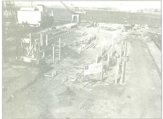
*Grada de lanzamiento de ASMAR (T) en etapa de hincado de pilotes (1979).*
