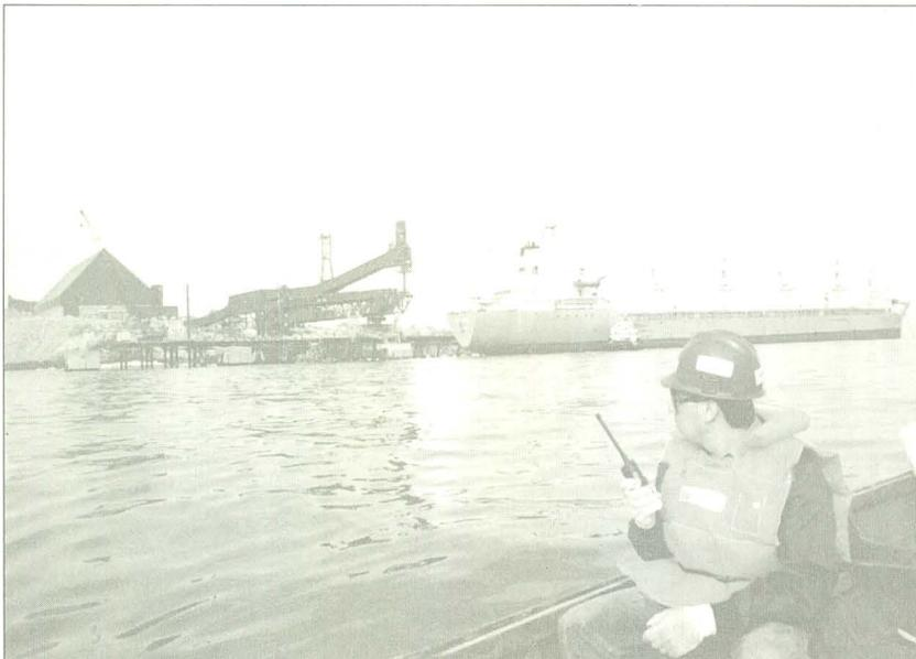
do por una estación de muestreo automático, llega hasta la parte superior del cargador, donde se encuentra el brazo de carga con su correspondiente correa transportadora.
