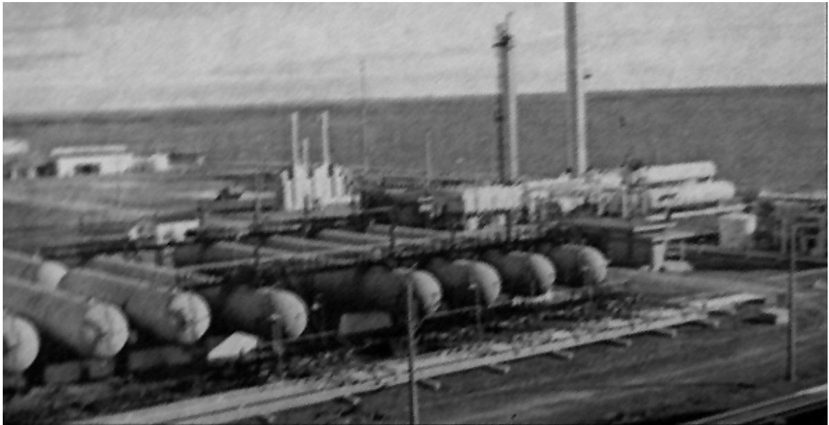
PLANTA DE CABO NEGRO QUE OPERA EN CONJUNTO CON LA PLANTA DE POSESION, REALIZANDO LA SEPARACION DEL PROPANO-BUTANO Y GASOLINA NATURAL
