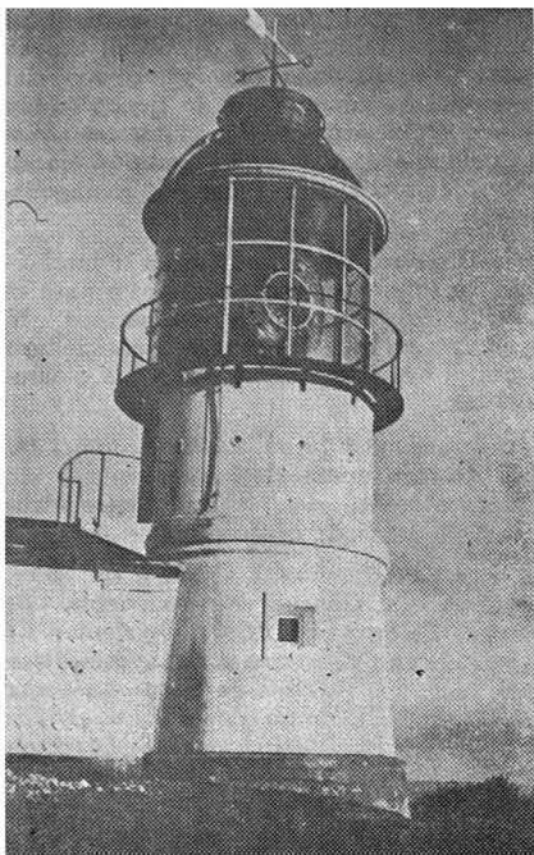
Torre y linterna de Faro Raper, en la Península Tres Montes. Potente faro de 20 millas de alcance, de vital importancia para el cruce del famoso Golfo de Penas.
