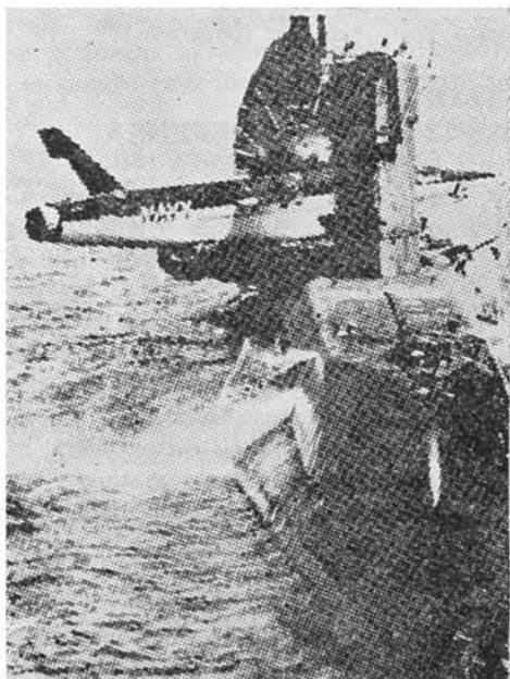
El único lanzamiento de un misil Regulus II por un buque lo efectuó el "Greyback" (SSG-574) el 16 de septiembre de 1958. La fotografía muestra la preparación y lanzamiento de este misil que tenía el doble de la velocidad y alcance del Regulus I, pero no su suerte. El Regulus II fue cancelado después de este vuelo, mientras que su antecesor tuvo más de seis años de servicio antes que él.
