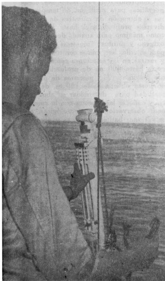
Una botella Nansen con su valiosa muestra de agua y datos de temperatura está próxima a ser retirada del alambre. El técnico tiene en su mano derecha un gancho de seguridad con el que asegurará la botella para evitar una posible pérdida del instrumento.
